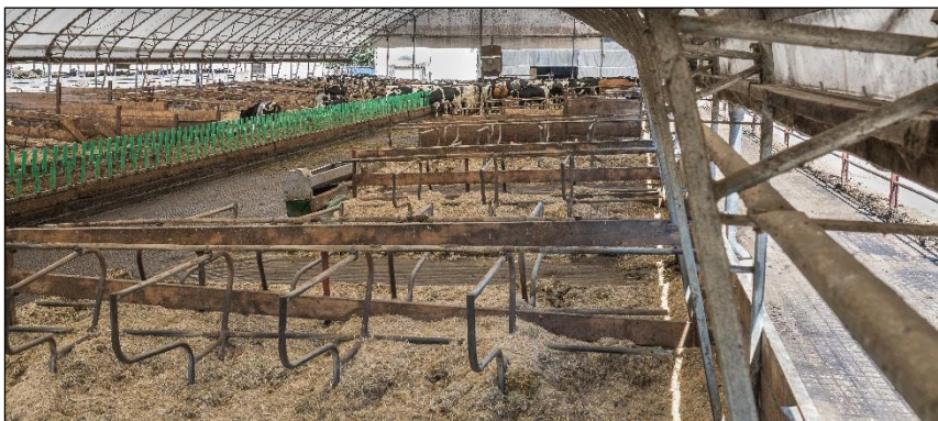
Abbildung 30) Tiere sammeln sich auf einem Projektbetrieb an der offenen Gebäudeseite. Der Rest des Stalls wird von den Tieren gemieden
